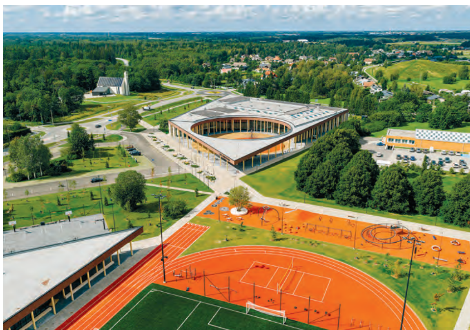
Foto: Tõnu Tunnel
